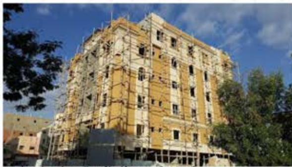
Al nhda Building 3m Sr.
